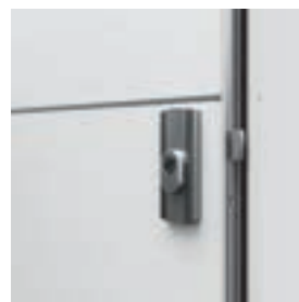
štvorbodový lištový zámok prispôsobený pre dve cylindrické vložky – KWARC Typ III
